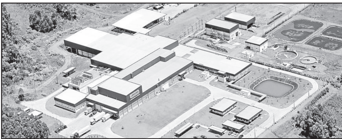
Frigorífico de Suínos, instalado no município de Poço das Antas
