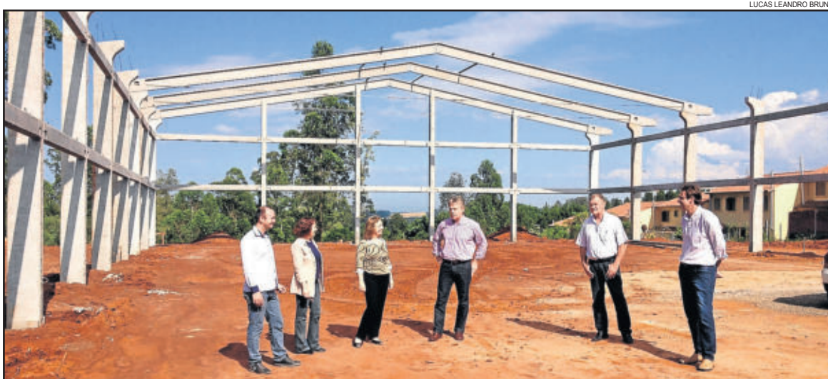
Avançam as obras para o ginásio de Esportes da EMEF Teobaldo Closs
