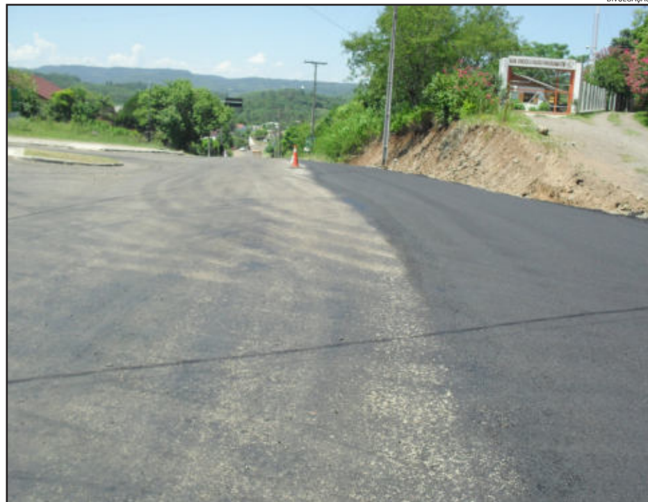
Obra foi concluída e é comemorada pela Administração Municipal
