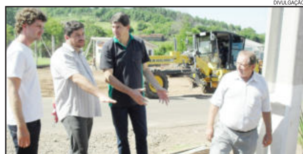
Na retomada do Executivo, primeira ação do prefeito foi acompanhar as obras em andamento
