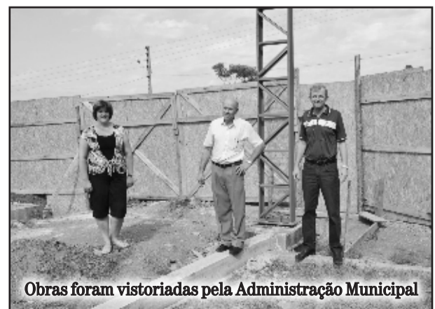
Quadra esportiva está sendo feita no Centro Municipal de Educação Poçoantense
