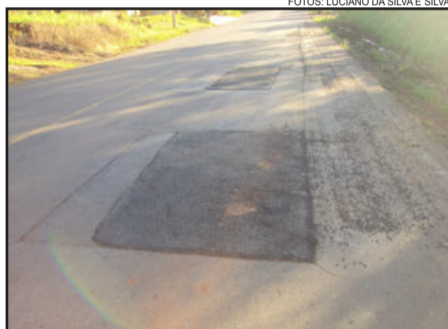
Reparos foram realizados no feriado
