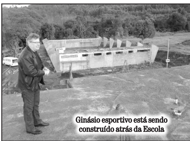
Marasca feliz com andamento das obras
