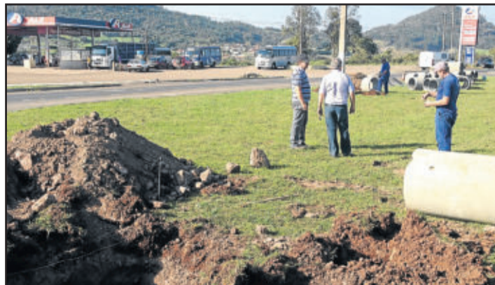
Funcionários de Westfália trabalham na base para os postes
