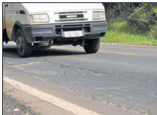
Remendos na rodovia também são situação de perigo, por falta de recuperação
