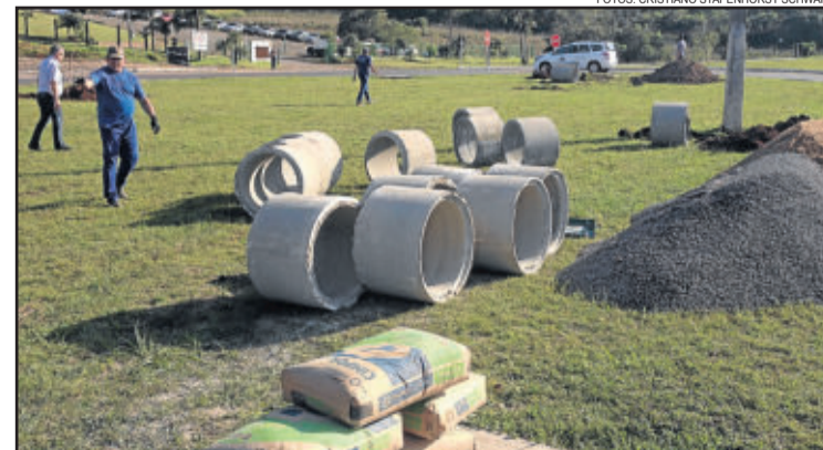
Trevo contará com 13 postes de iluminação
