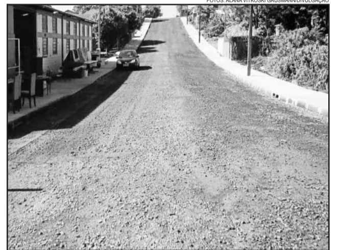
Pavimentação da Rua Bruno Driemeyer
