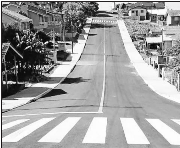
Pavimentação na Rua Raimundo Dhamer
