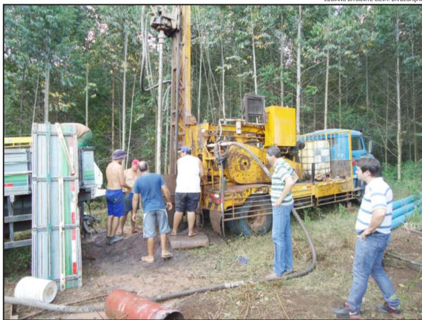
Prefeito acompanha de perto os trabalhos de perfuração do poço artesiano
