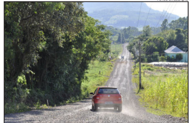
Pavimentação iniciará na curva que leva a Pontes Filho
