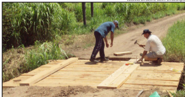
Servidores realizando a troca das madeiras
