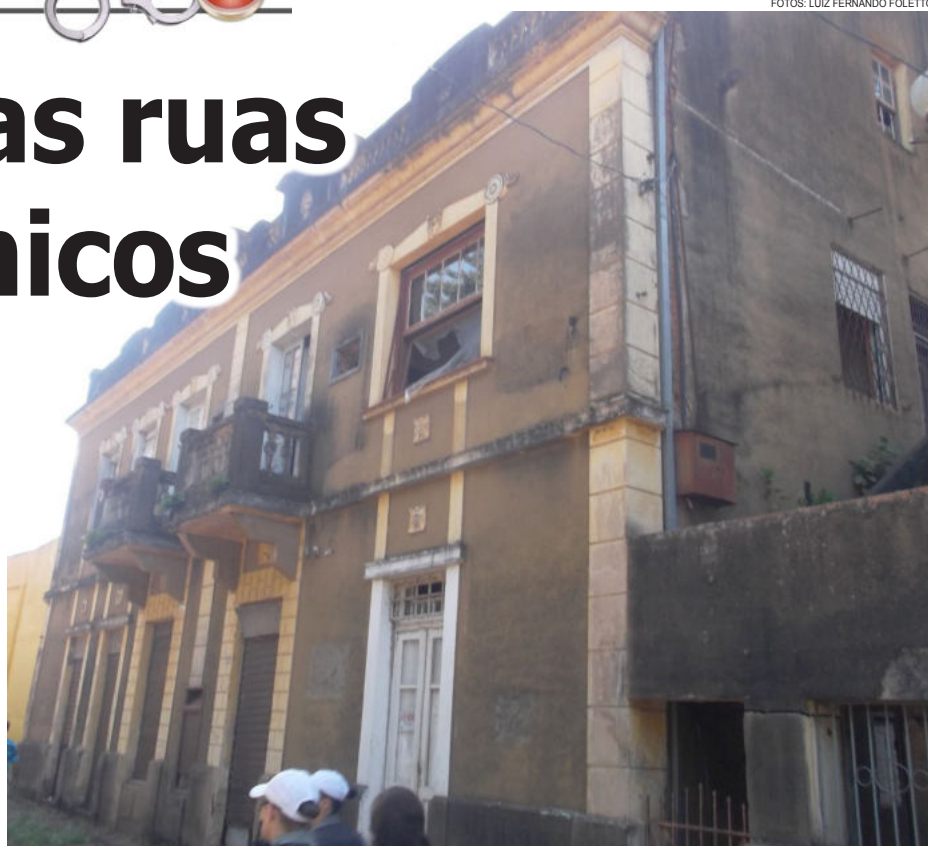
Casarão é usado pelos usuários de crack
