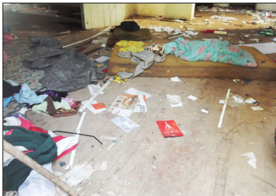
Interior do casarão
