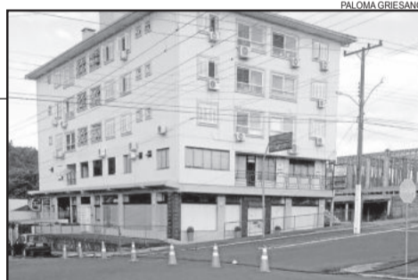
Caminhão arrancou cabos de telefonia e interrompeu o trânsito
