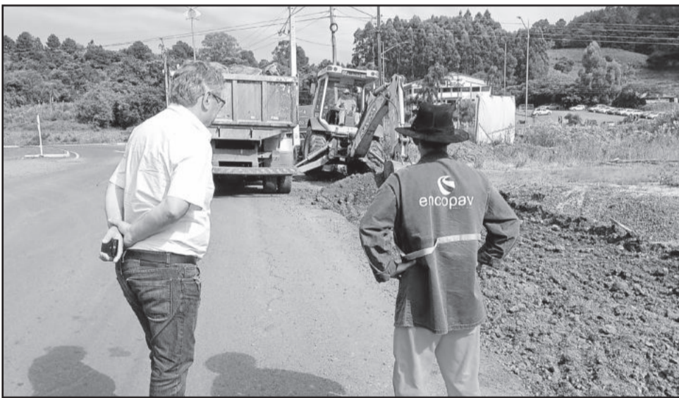
Prefeito Sérgio Marasca acompanha obras de perto. Trecho da ciclovia da Rota do Sol até a Avenida Central
