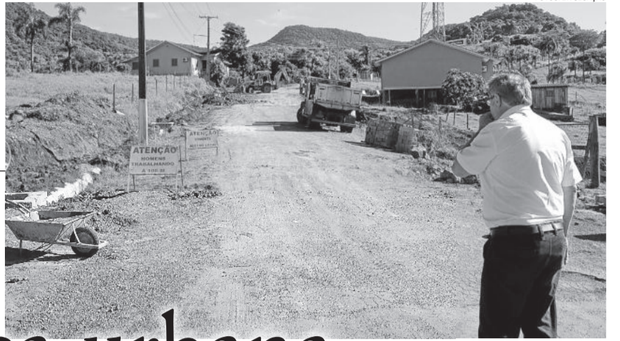
Rua próxima à Escola Estadual será pavimentada
