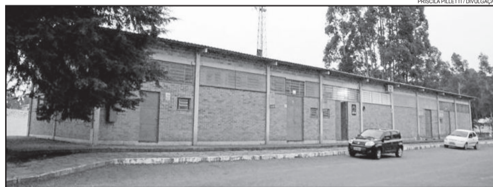
Empresas estão instaladas nos oito módulos de 50m 2 cada
