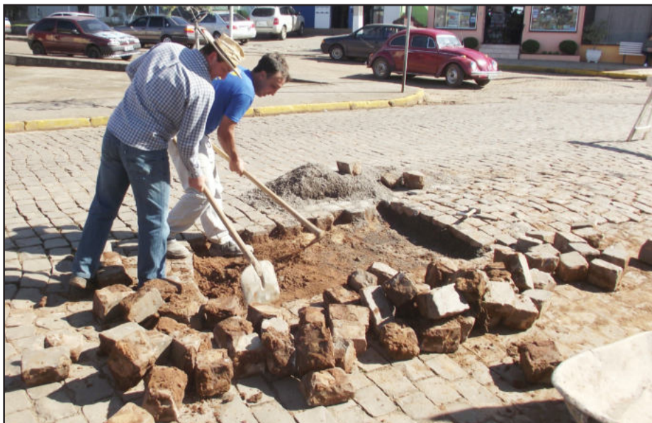
Melhorias são realizadas na Rua 4 de Julho, no Centro de Paverama
