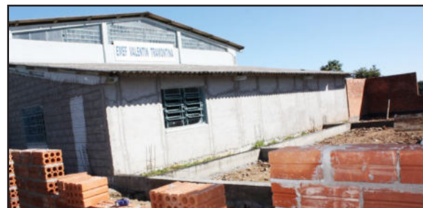
Obras na Escola Valentin Tramontina seguem em ritmo acelerado
