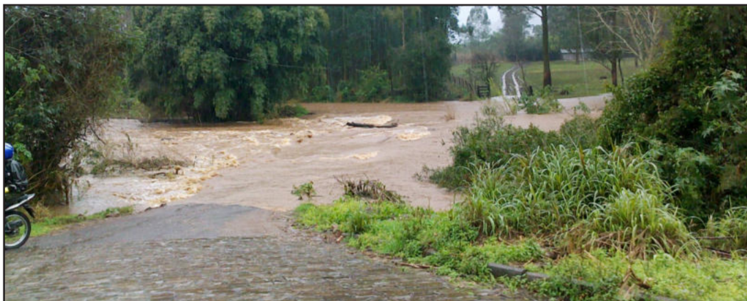
Ponte sobre o Arroio Boa Vista, no Bairro Boa Vista, ficou interrompida
