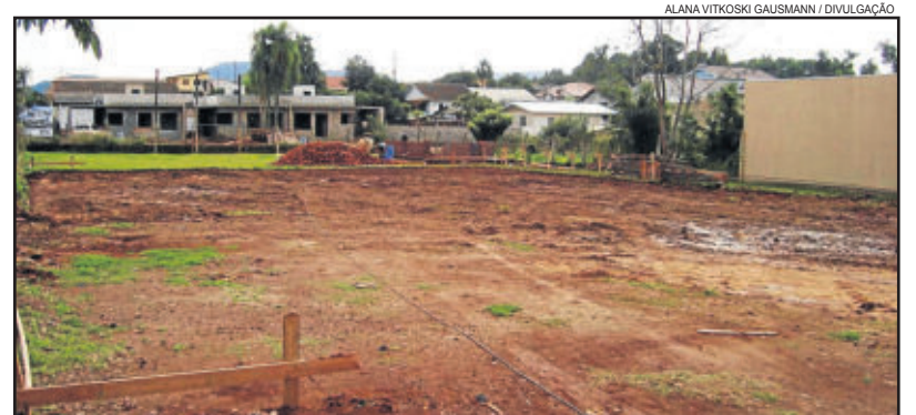
Quadra poliesportiva está sendo construída no Bairro Alesgut
