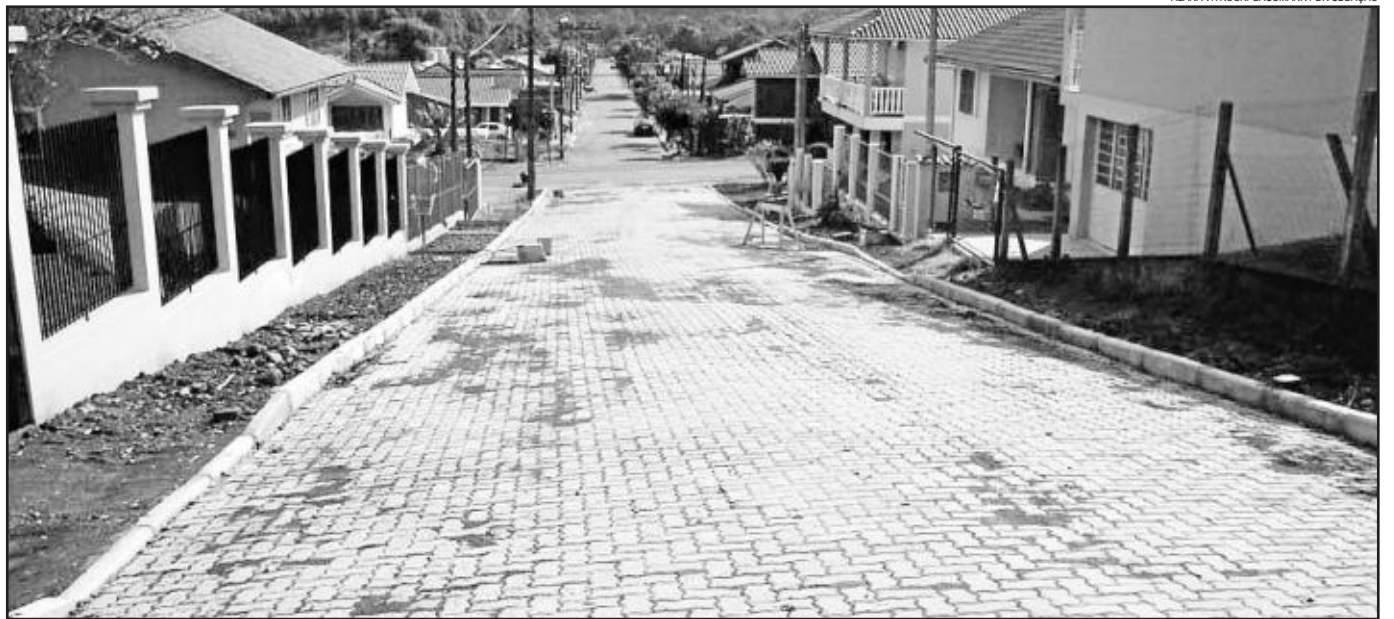
Rua Lauro Dickel, no Bairro Languiru, recebeu pavimento com blocos de concreto intertravados (paviesse)
