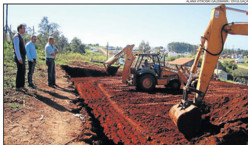
Terraplenagem antecede o início da construção estrutural do ginásio
