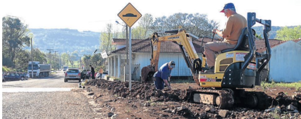
Tubulação para colocação dos postes está sendo construída
