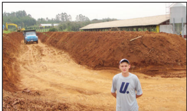
Terraplenagem para construção de chiqueirão
