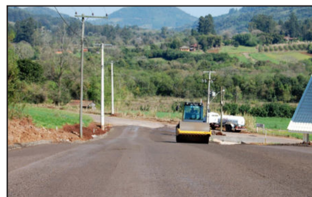
Obra atingiu a fase de compactação
