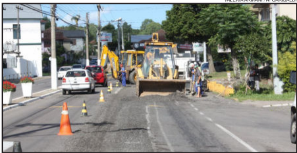
Obras na Avenida Independência
