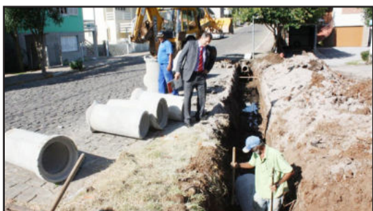
Obras na canalização da Rua João Goulart
