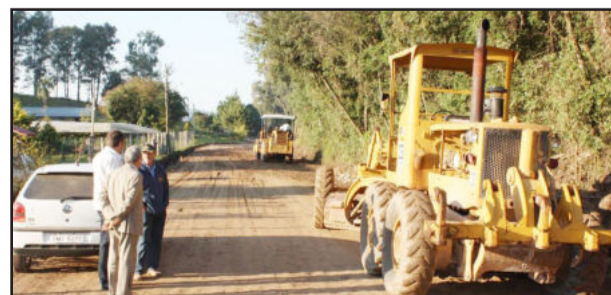
Obras de pavimentação avançam em São José da Costa Real
