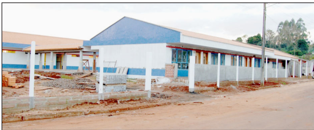
Obra está na fase de acabamentos
