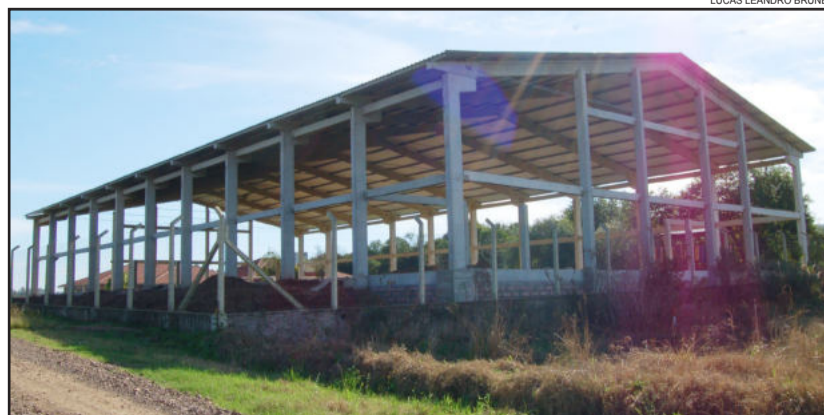
Ginásio de esportes da EMEF Alfredo Schneider
