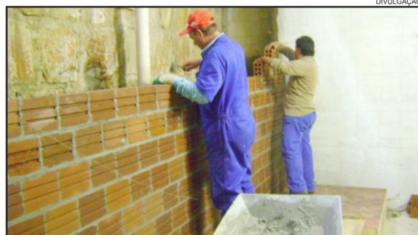
Profissionais da prefeitura durante as obras junto Escola de Música
