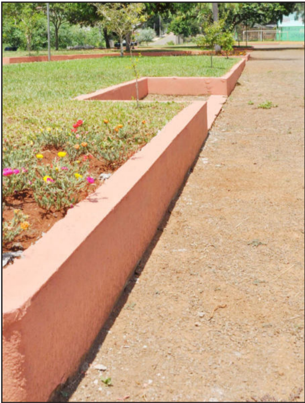
Muretas das praças estão sendo pintadas na cor salmão, como no Bairro Campestre
