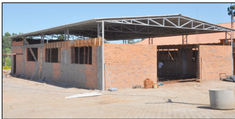
Nova construção abrigará o auditório do Parque da Expoagro Afubra
