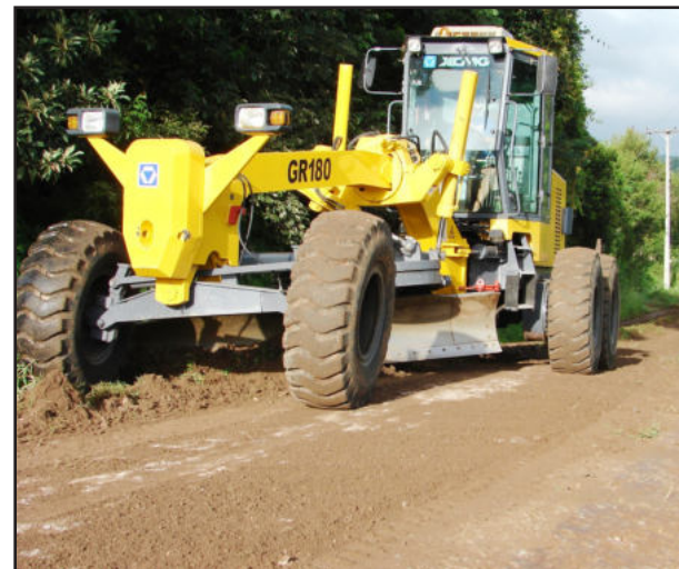
Motoniveladora realiza melhoria na parte não pavimentada
