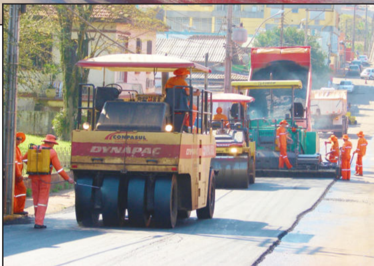
Obras de asfaltamento da Rua Carlos Arnt
