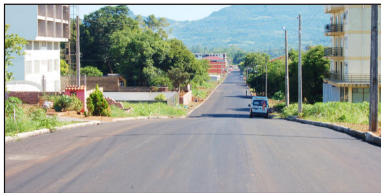
Obra está concluída na Rua 2 Leste
