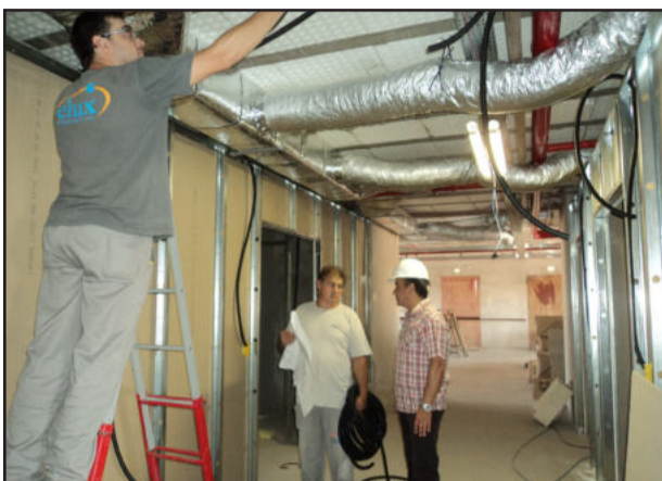
Engenheiro civil Élbio Dutra (D) confere andamento das obras da Unidade de Quimioterapia
