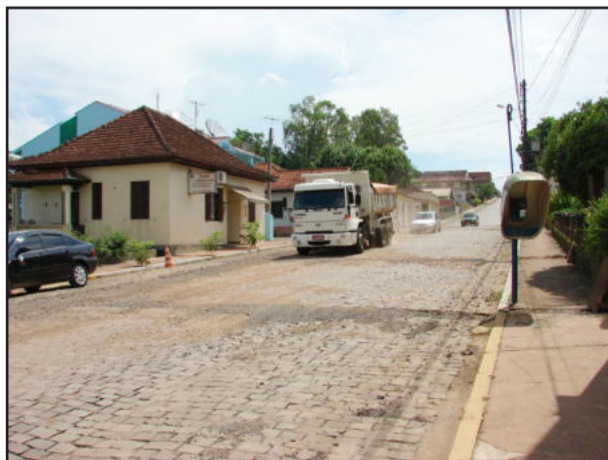
Corsan substituiu a canalização de cimento amianto por PVC na Rua Maurício Cardoso
