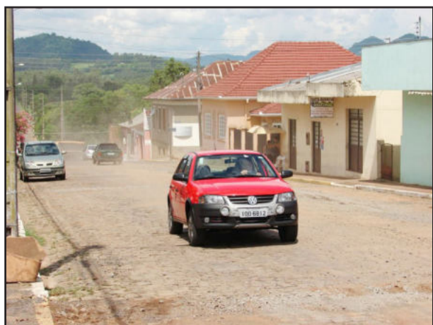
Obras na canalização da Rua Maurício Cardoso beneficiam a população
