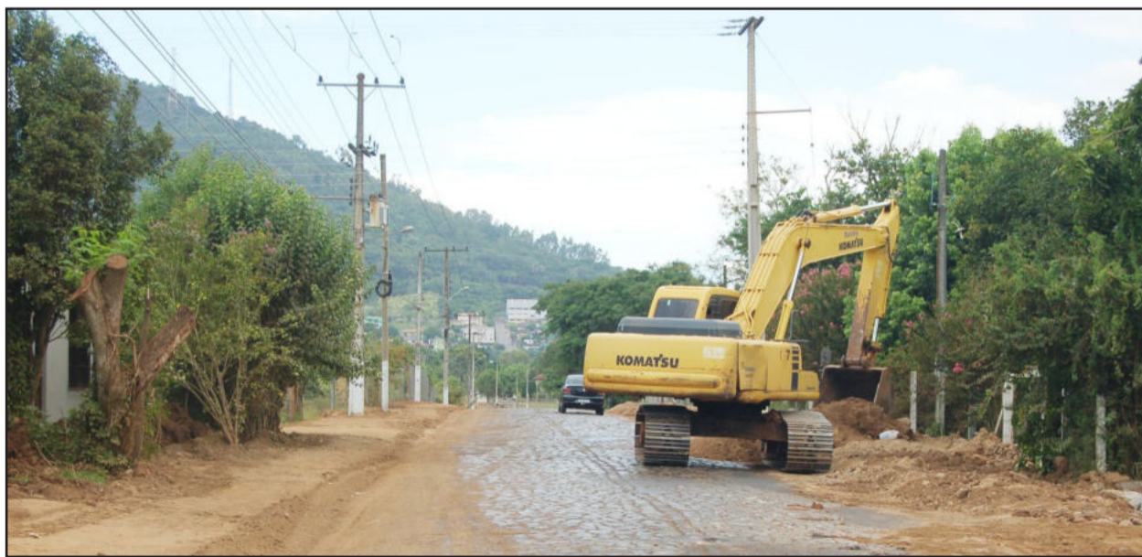
Obras na Várzea do Bairro Teutônia
