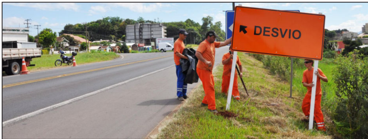
Sinalização provisória já está sendo colocada no local, porém, permanece coberta
