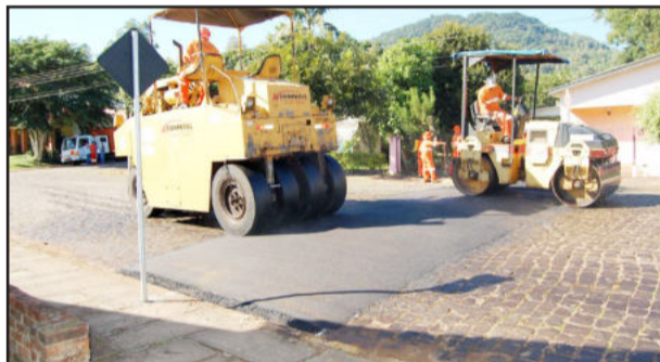
Empresa Conpasul concluiu a implantação de Lombadas
