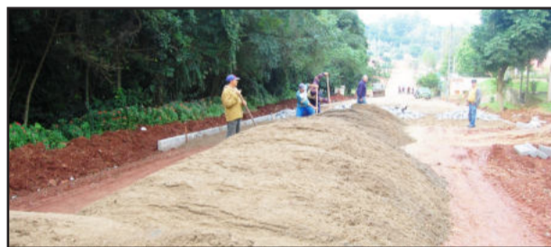
Rua Estrela, no Bairro Olarias, está sendo pavimentada no sistema de contribuição de melhoria
