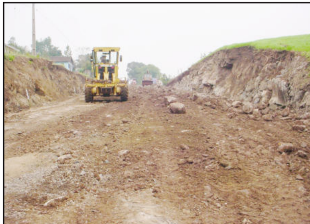
Alargamento da Estrada Velha
