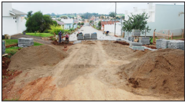
Rua Ondina Pereira, no Loteamento, Verdes Vales recebe bloquetes de concreto
