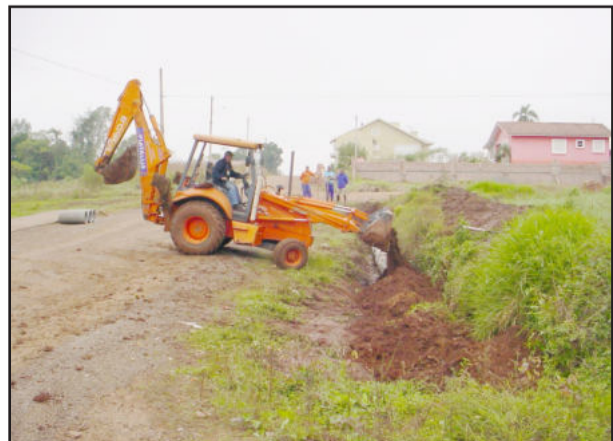
Canalização da Rua 2 Leste
