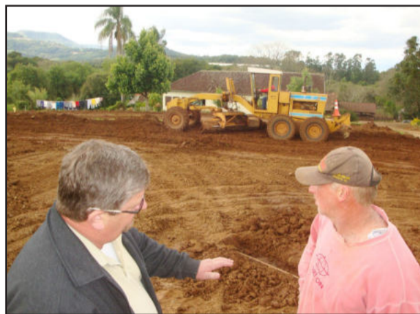
Secretário Paulo Scheeren (e) e o produtor Airton Hann acompanhando serviço de terraplenagem
