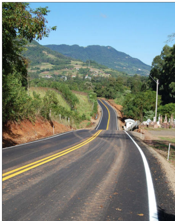
Investimento em pavimentação asfáltica, como no acesso para a Linha Imhoff
