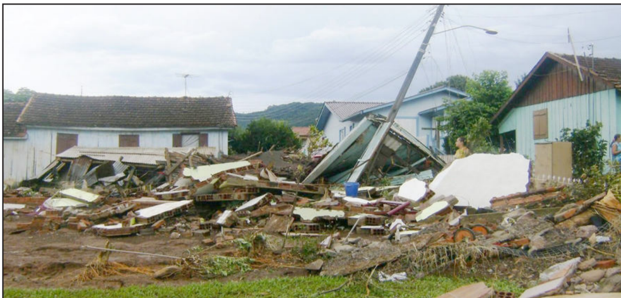
Objetivo da campanha é a reconstrução de casas derrubadas pela enxurrada
