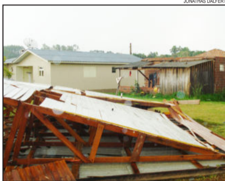
Telhado ficou nos fundos da residência onde mora o casal Wommer, na Vila Esperança
