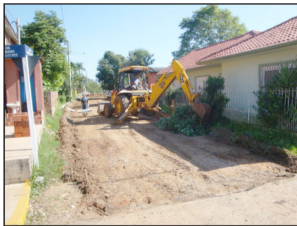
Rua Isabel Schuh em obras
