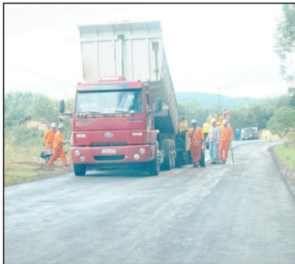
Obras na rodovia prosseguem
