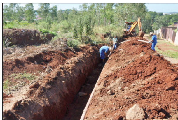
Obras de canalização exclusiva para o PPCI da nova área industrial do município tiveram início nesta terça-feira
