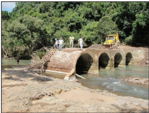
Bagatini, Cerbaro e Dalcin verificaram o andamento das obras na ponte de Colônia Jardim
