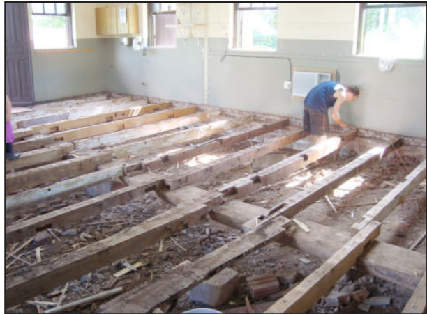
Assoalho está sendo trocado
