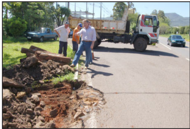
Obras no trevo da Paquetá
