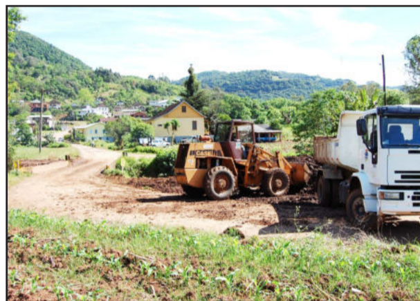
Obra em andamento no Bairro Daltro Filho
