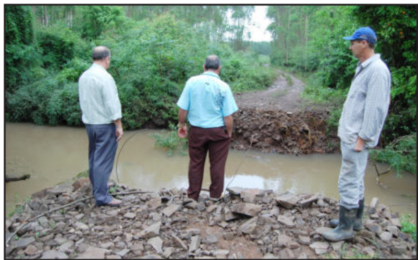
Força da água levou a ponte
