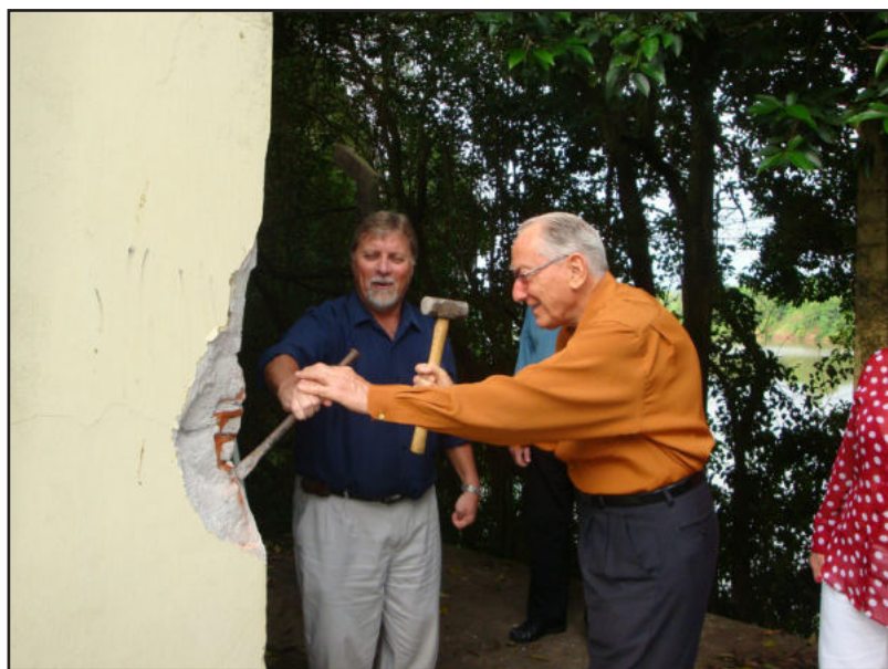
Prefeito Celso Brönstrup (e) e o médico Werner Schinke no ato simbólico de início da demolição
