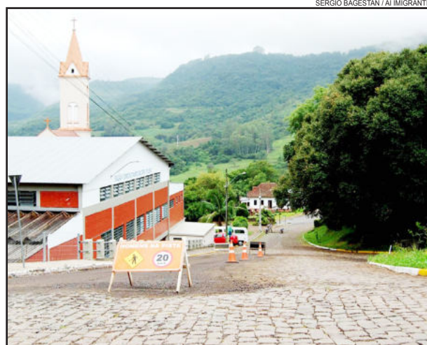
Rua Frei Tiago recebe recomposição de pavimento
