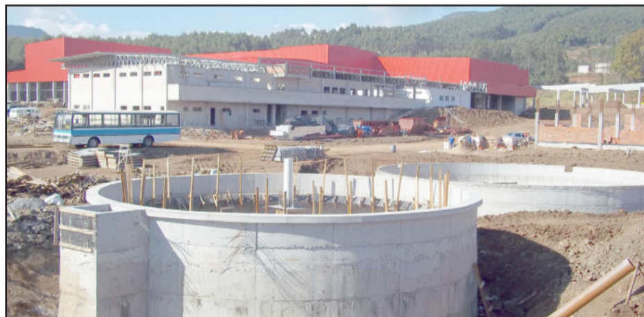
Em maio de 2011, a construção continuava em rápido andamento
