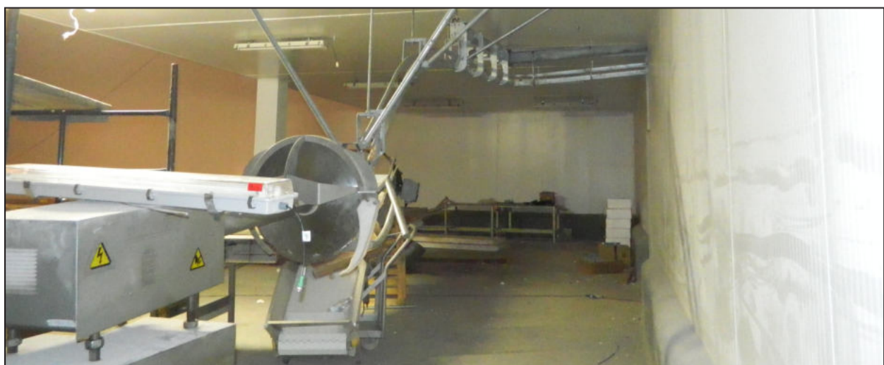
Parte interna do frigorífico ainda está em obras
