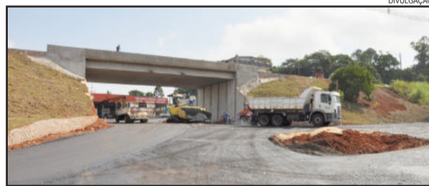
Obras de asfaltamento da base
