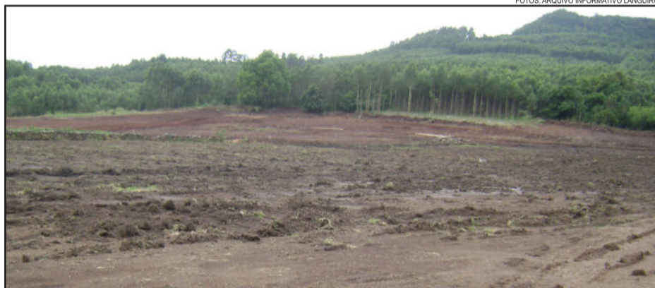
Terraplenagem em novembro de 2009
