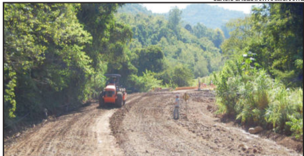
Alargamento e futura pavimentação na Avenida Ipiranga
