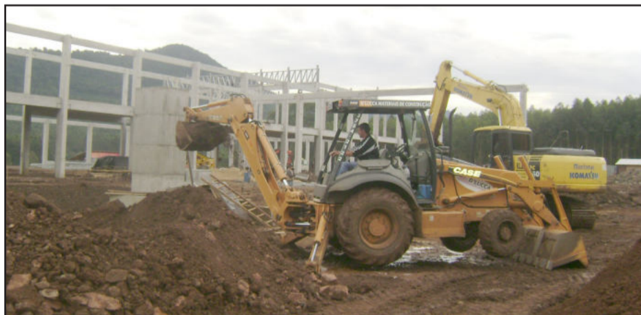
Obras em julho de 2010
