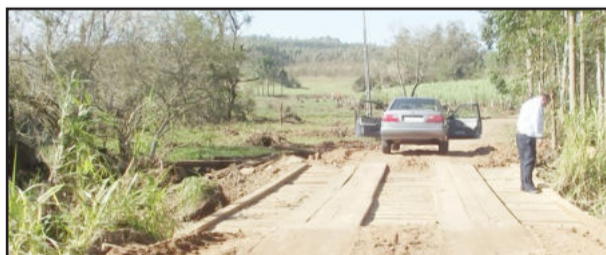
Ponte em Bom Jardim
