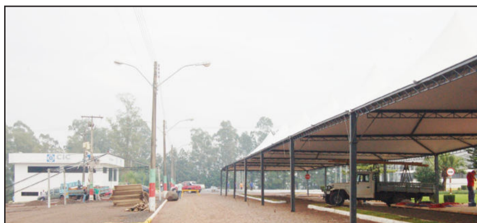
Segue a montagem da estrutura para receber a Festa de Maio, para a Praça de Alimentação
