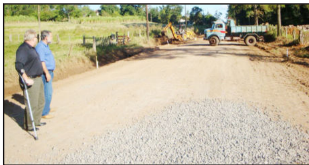
Rua Júlio de Castilhos será prolongada com pavimentação asfáltica até a RS-129
