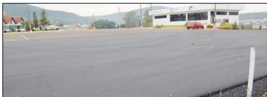
Área asfaltada defronte a CIC foi ampliada para dar mais qualidade à Festa de Maio, dentro do Parque de Eventos
