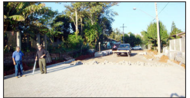
Rua Aldino Alfredo Sulzbach, no Bairro das Indústrias, pavimentação com bloqueto de concreto
