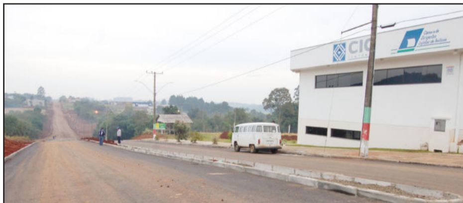
Avenida 2 Oeste foi asfaltada dentro da área do Parque de Eventos
