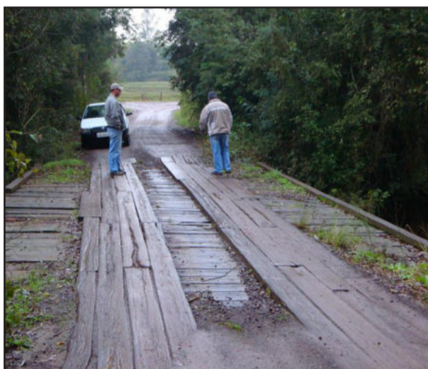
Ponte sobre o Arroio Estrela será demolida
