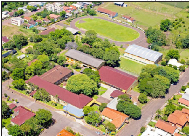
Foto aérea do Colégio Teutônia feita em 2011 mostra parte da estrutura disponibilizada à comunidade escolar
