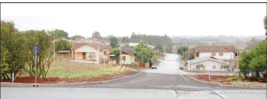
Rua 31 de Março está com a imprimação pronta
