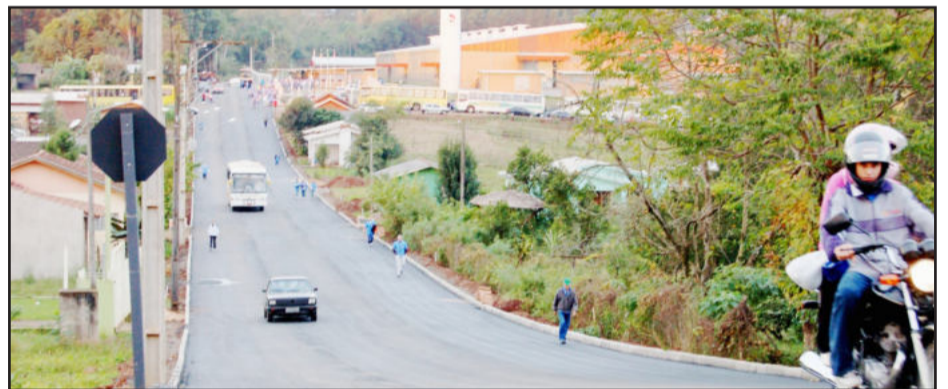
Rua Arnaldo Krug está com a pavimentação concluída
