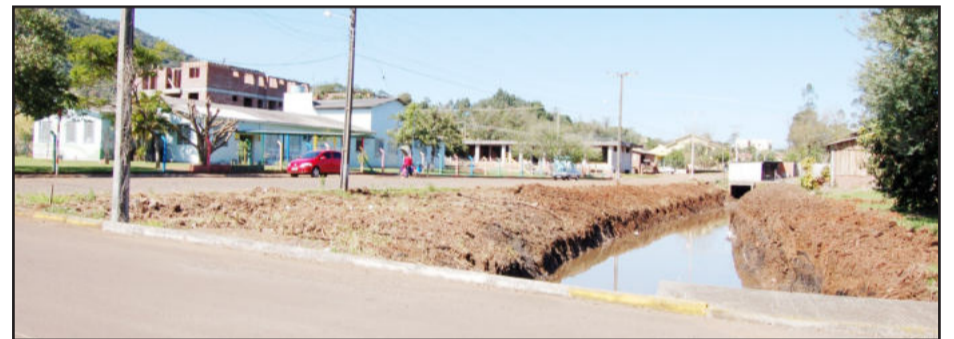
Construção da galeria pluvial no Bairro Languiru
