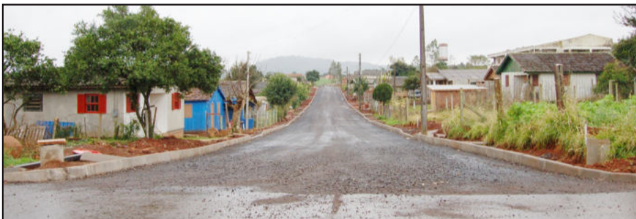
Rua 50 está com a imprimação concluída
