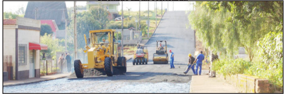
Capeamento da Rua Carlos Arnt, em Canabarro, no trecho entre a Estrada Velha e a Rua Leopoldo Schneider
