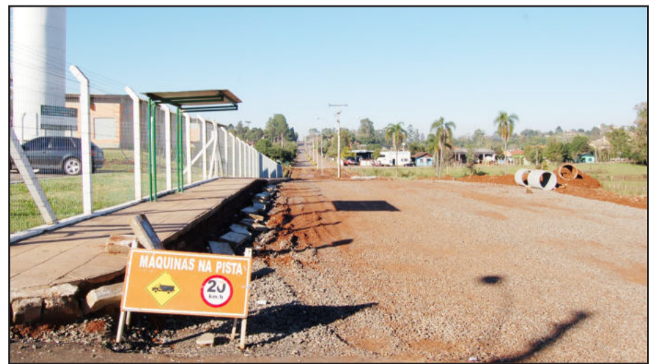
Pavimentação da Rua Otterno Schaeffer
