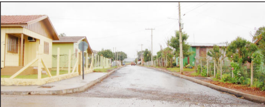
Rua 51 também aguarda capa asfáltica final
