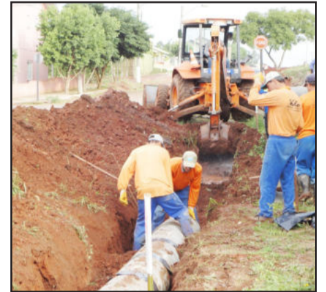
Início das obras de pavimentação da Rua 2 Leste
