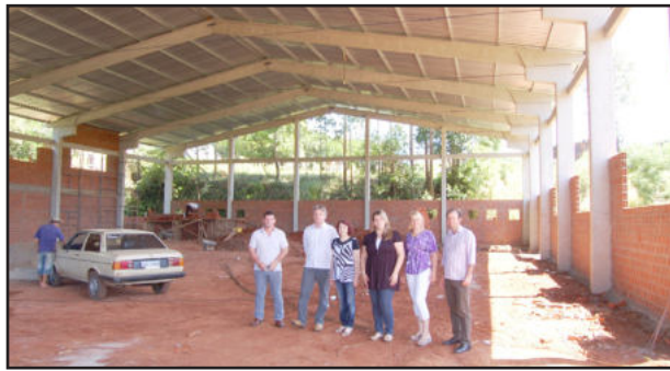
Evoluem as obras de construção do ginásio do Loteamento 8, na Escola 24 de Maio
