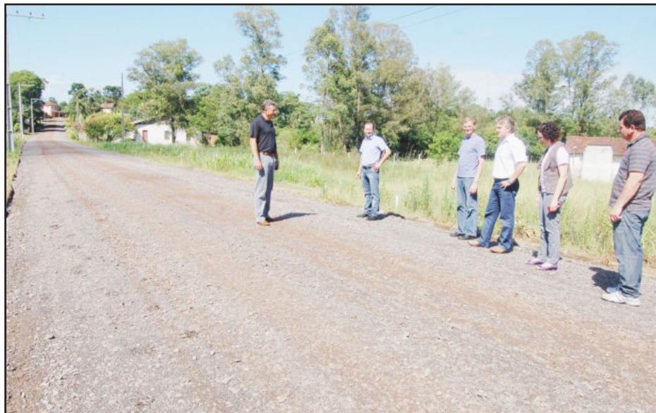
Começaram as obras de pavimentação da estrada de Posses
