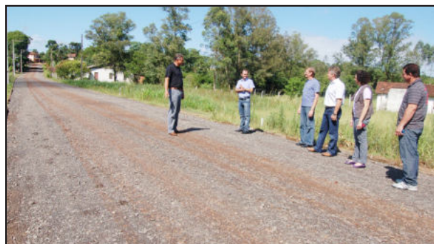
Começaram as obras de pavimentação da Estrada de Posses
