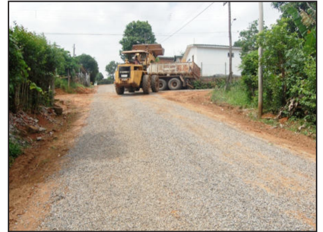
Ruas recebem camada de brita
