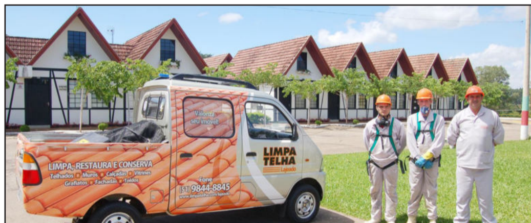
Equipe do Limpa Telha executou a aplicação do produto, que age com a água da chuva
